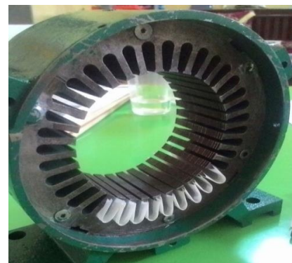
Gambar 6 Pemasangan isolasi pada alur-alur di inti stator
