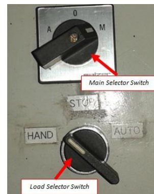
Gambar 5 Interfacing panel pada operasi manual
