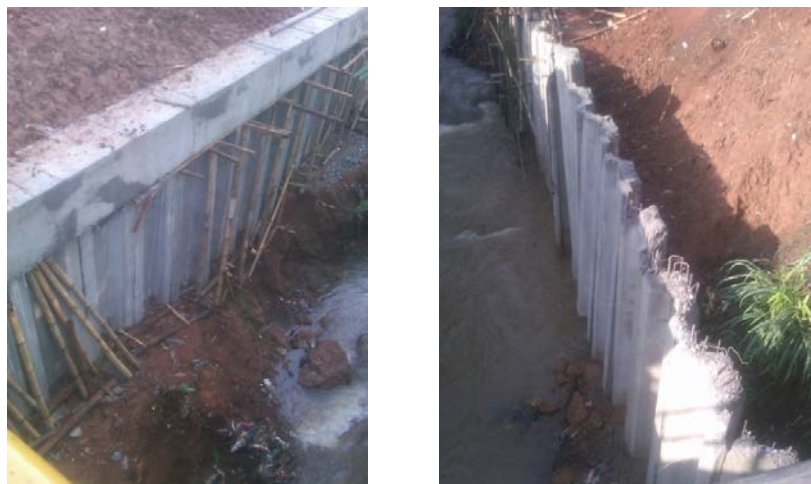
Gambar 2. Contoh Pemasangan Sheet Pile pada Dinding Sungai (sumber gambar @nicopradhika)
