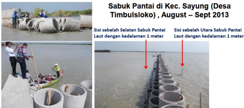
Gambar 9 Aplikasi pemecah gelombang di Desa Timbulsloko, Kec. Sayung Kab. Demak (Sumber: Sugianto, 2020)
