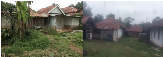
Gambar 1. Kondisi Lingkungan Perumahan
